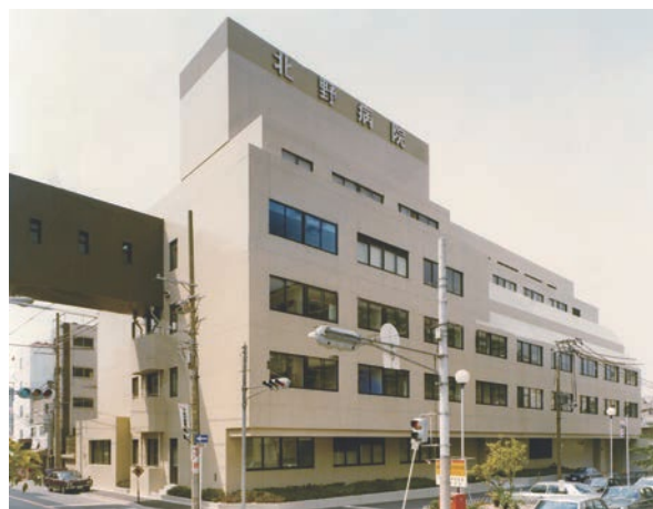
増築された西館
