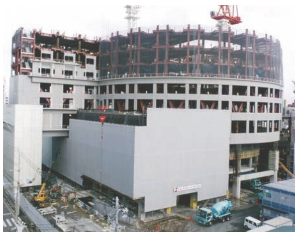
建設中の本館
