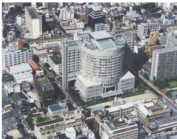
完成後の本館
